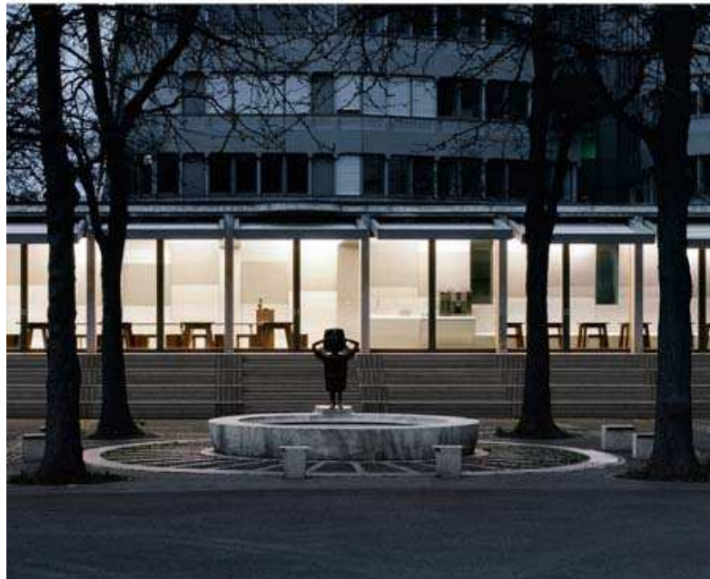
Der Einbau öffnet sich mit einer gesamten Längsseite zum Pausenhof des Kirschgartenschulhauses (alle Bilder: Tom Bisig)
